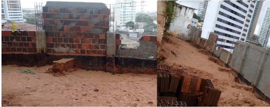
Figura 5 – Comportamento do solo e estrutura momentos antes do segundo colapso. Fonte: Acervo próprio, 2016.
